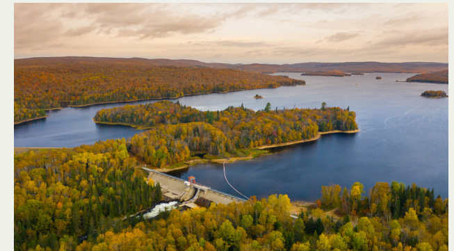
Réservoirs et barrages
