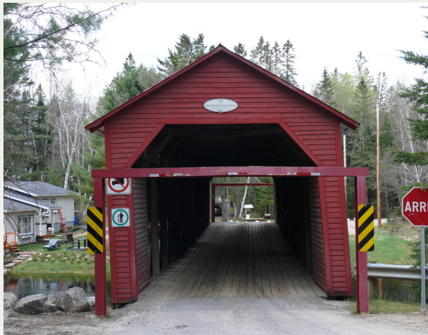
Pont couvert Armand-Lachaine, Chute-Saint-Philippe (2021)
